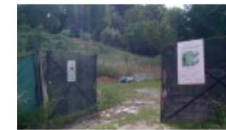
Terni, Circolo Prampolini: cantiere abbandonato
